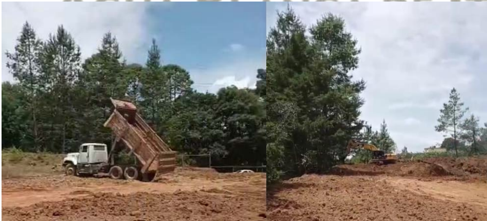
CAMIÓN Y EXCAVADORA HACIENDO TRABAJOS DE MOVIMIENTO DE TIERRAS
